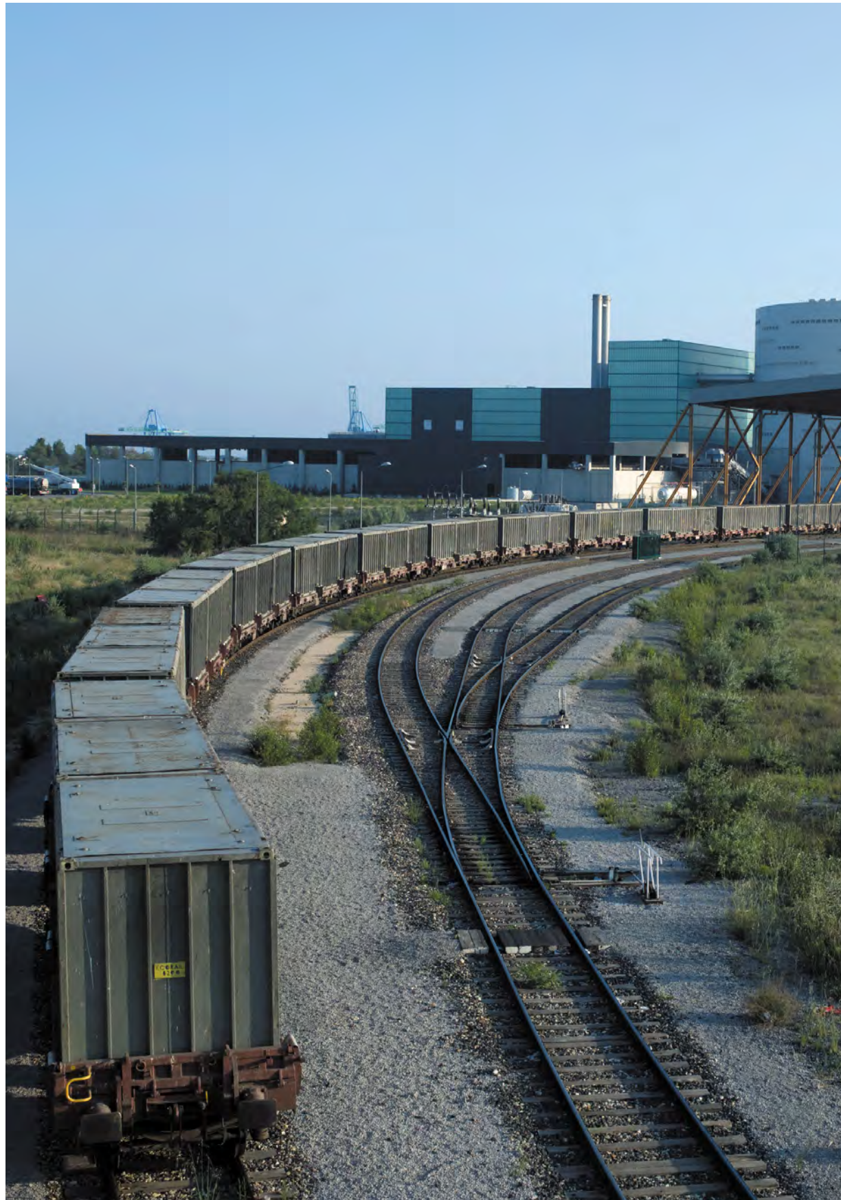
Le centre de traitement multifilières (source : EveRe).
