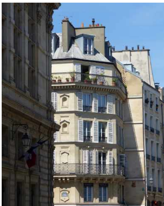
La Ville de Paris et l'ANABF travaillent ensemble sur la rénovation énergétique des logements situés dans le bâti haussmannien, qui fait partie du patrimoine architectural de la ville
