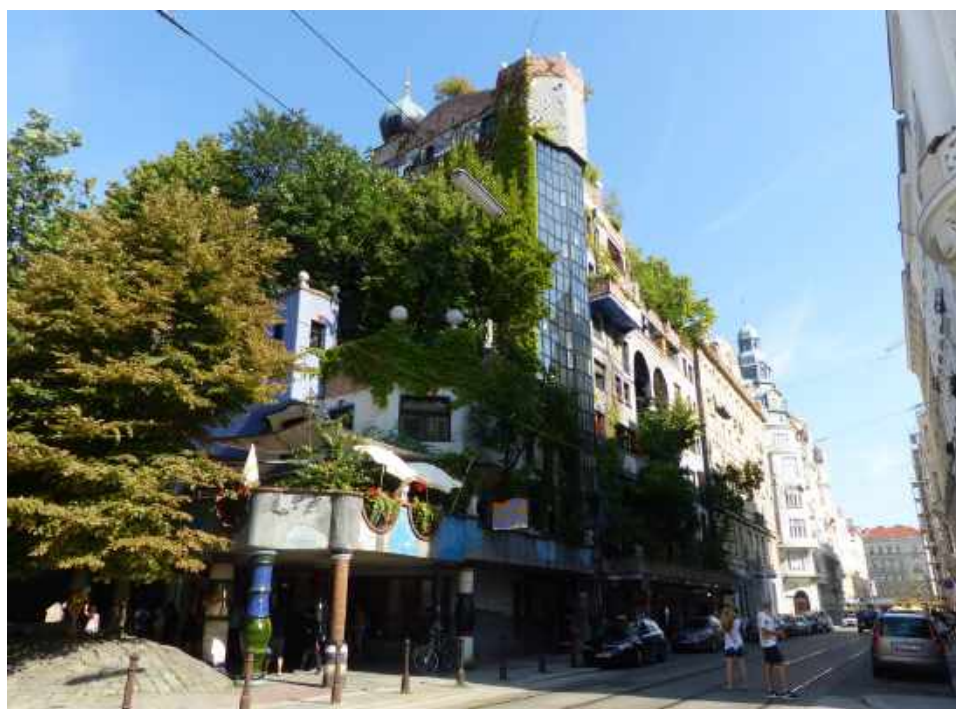
La maison de Hundertwasser, à Vienne
