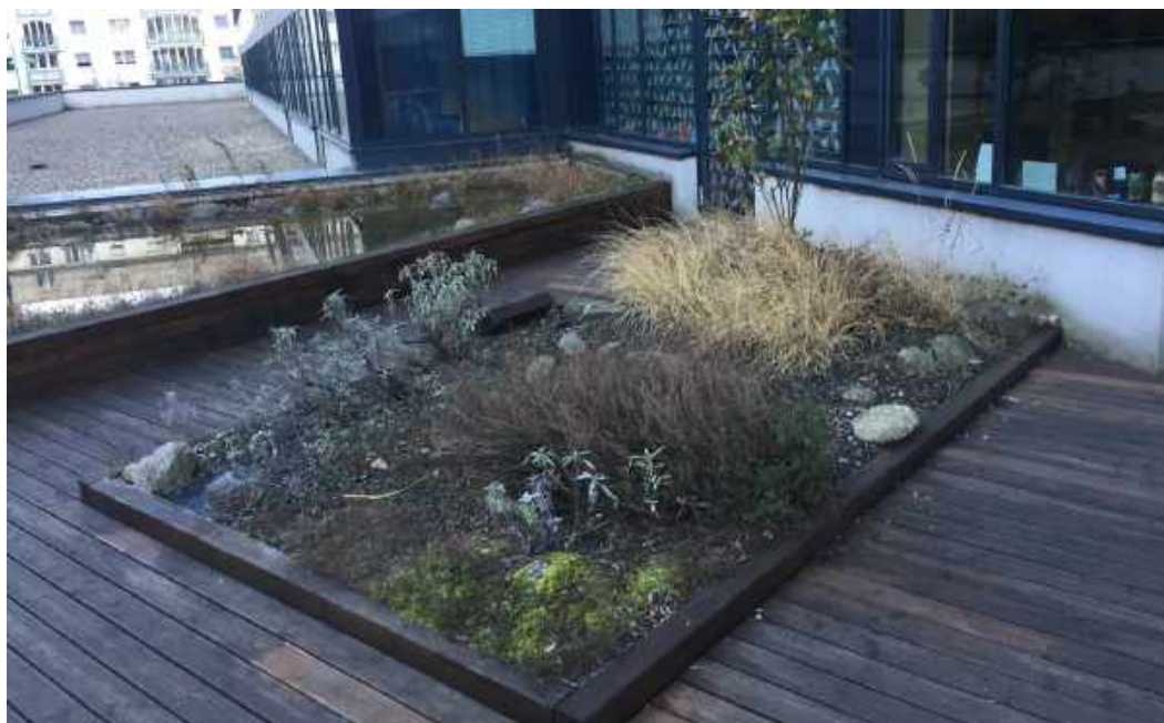
Une toiture végétalisée sur le bâtiment administratif abritant le Département pour la protection de l'environnement (MA 22) à la Ville de Vienne
