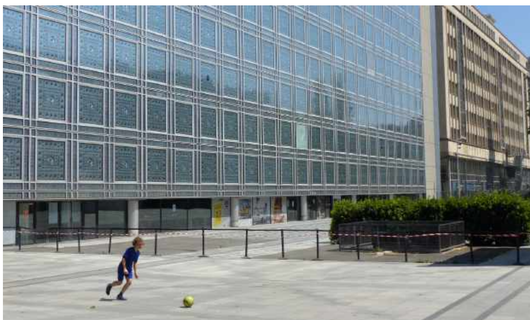
Les mourachabiehs de la façade de l'Institut du Monde Arabe à Paris
